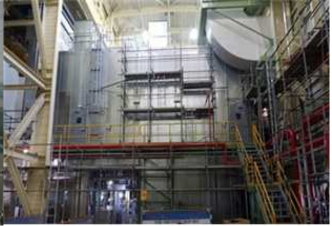
GT Enclosure 설치
