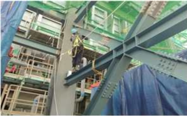
HRSG 철골 설치
