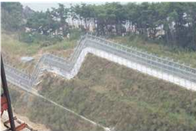
법면보호 및 보안시설 설치
