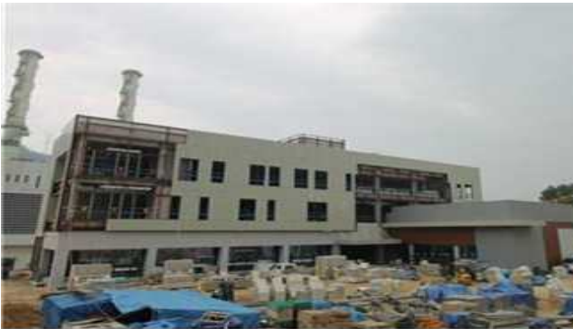
건축 - 관리동 건축 공사
