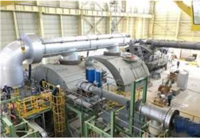
ST LP Cross Line 설치
