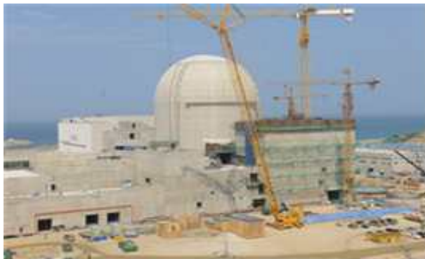
2호기 원자로건물 공사현장 전경
