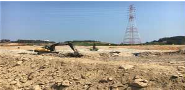
본관 기초굴착 공사
