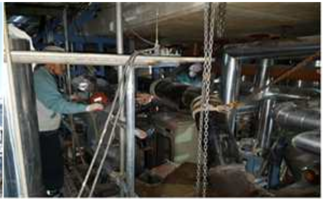
터빈 및 발전기 부대설비 설치공사
