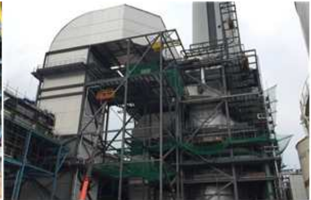
탈황설비 마감 보온작업
