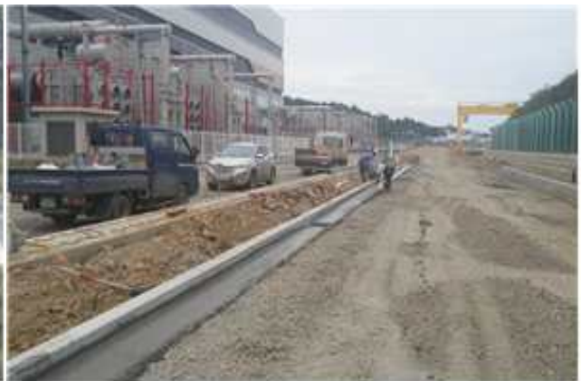
구내도로 경계석 설치 및 포장
