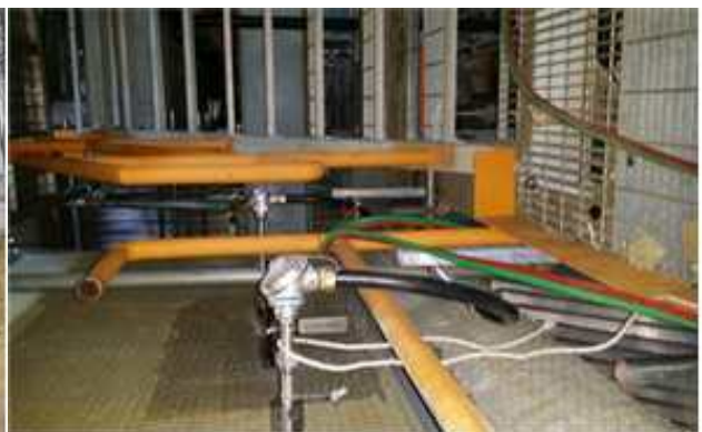
케이블 트레이 및 전선관 설치공사
