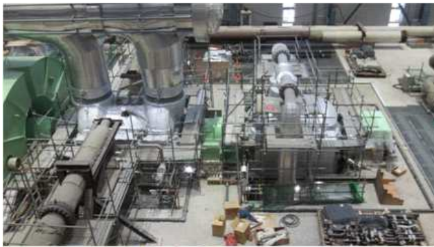
#10 터빈 및 발전기 설치공사
