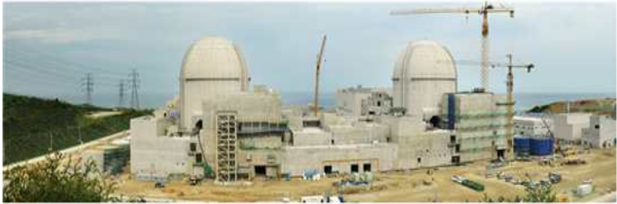
본관건물 공사현장 전경
