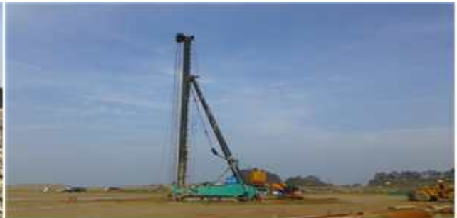
본관 지반보강 공사
