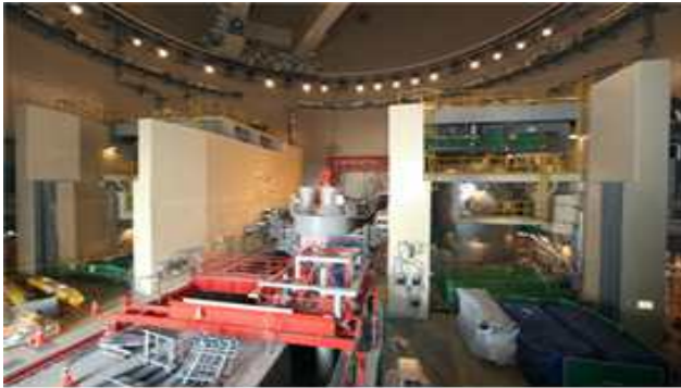
4호기 원자로건물 공사현장 전경
