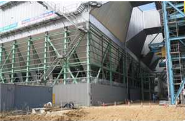
집진기 방풍벽 설치
