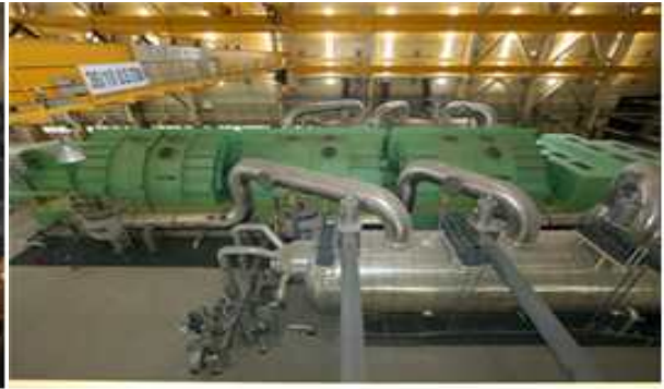
4호기 터빈건물 공사현장 전경
