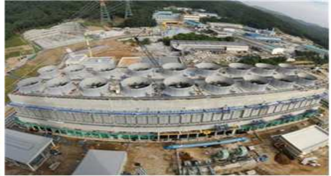
기계 - 냉각탑 설비 설치
