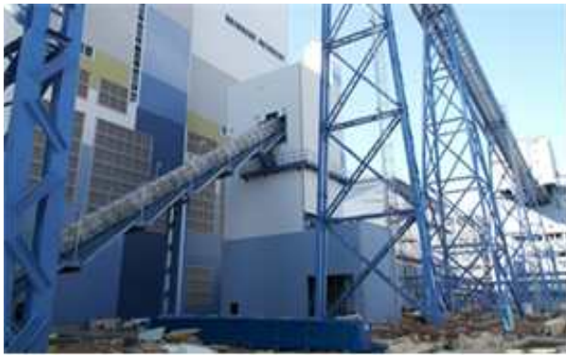
보일러 및 부대설비 설치공사
