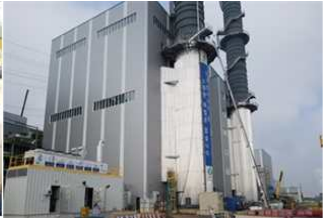
HRSG 빌딩 패널 설치
