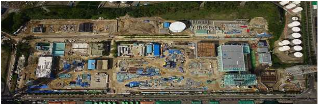
영남 건설현장 전경 ('16.9월말 기준)
