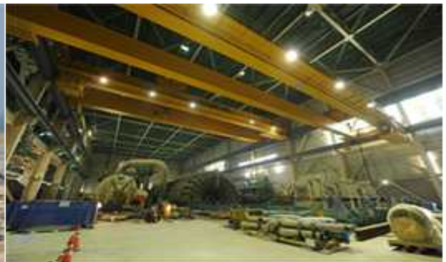
2호기 터빈건물 공사현장 전경
