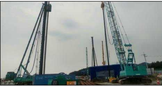
냉각수 심층취수로 가호안 시트 파일공사
