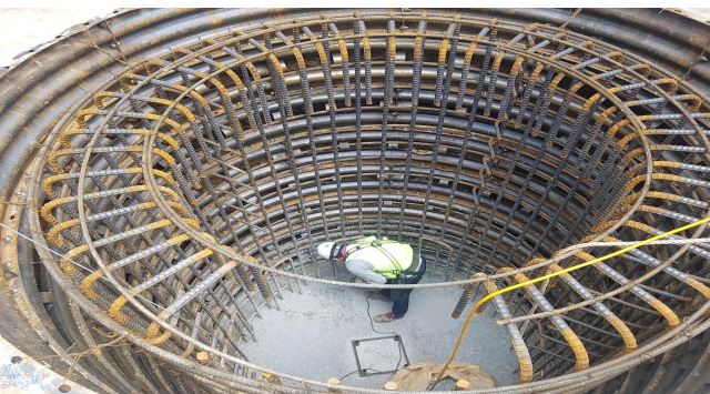
345kV 송전선로 철탑 기초공사
