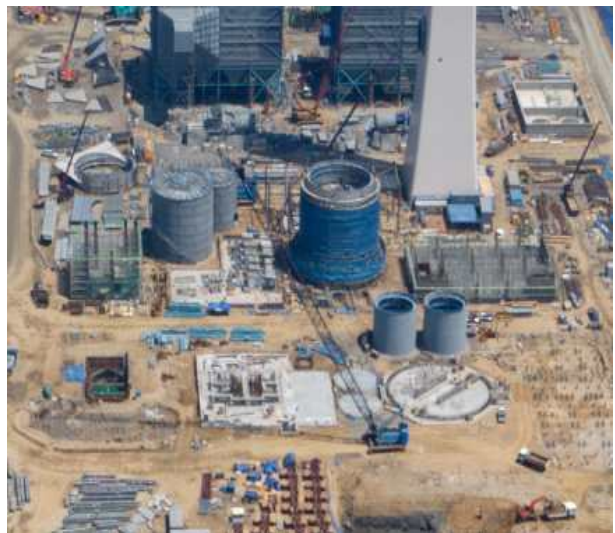
탈황설비, 전기집진기 설치공사
