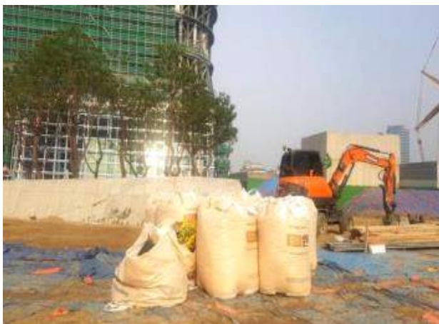
본체 상부 조경공사
