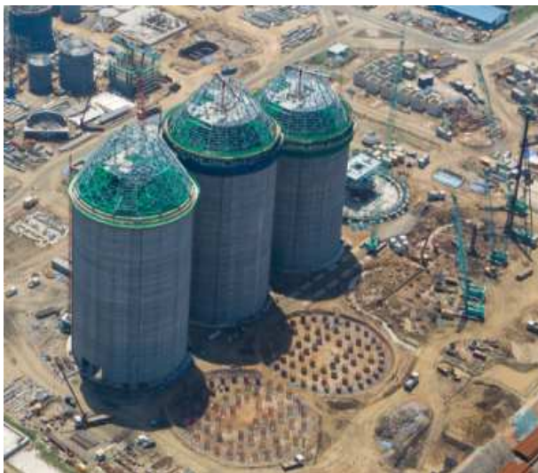
석탄취급설비 기초공사 및 설치공사
