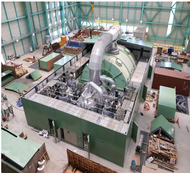
ST Enclosure 설치
