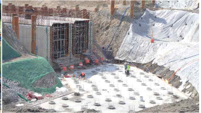
냉각수 배수관로 축조공사
