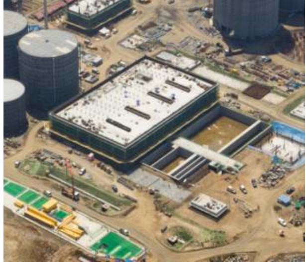
용수 및 환경건물 신축공사
