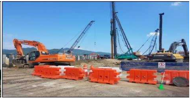
방파제 케이슨제작장 축조공사
