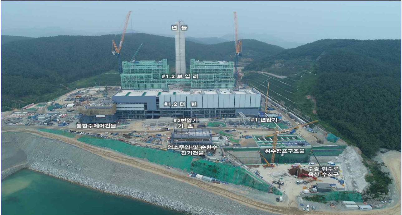
발전소 본부지 전경
