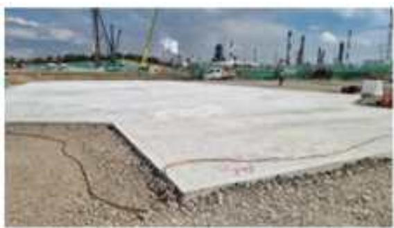
HRSG동 기초 설치공사
