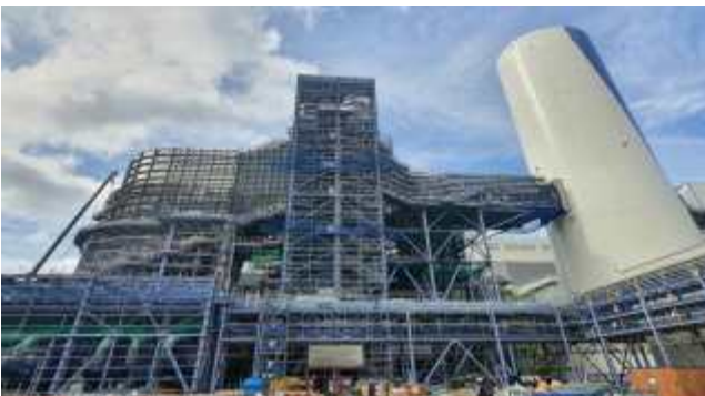
Absorber & Reheater#2 설치공사
