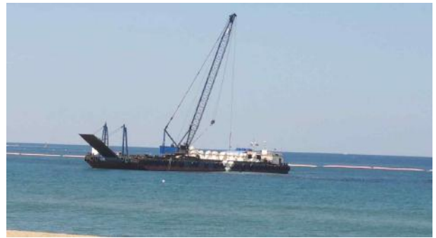
(침식저감) 수중방파제 덤플거치
