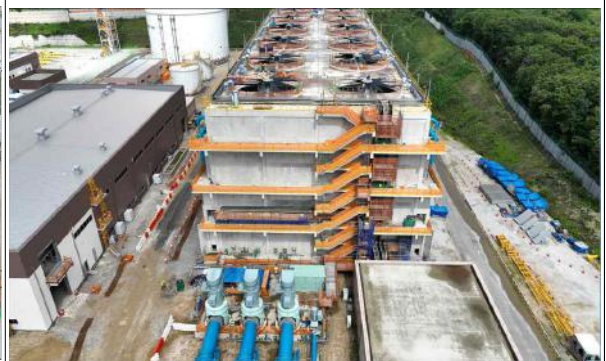
수처리동 및 냉각탑 전경
