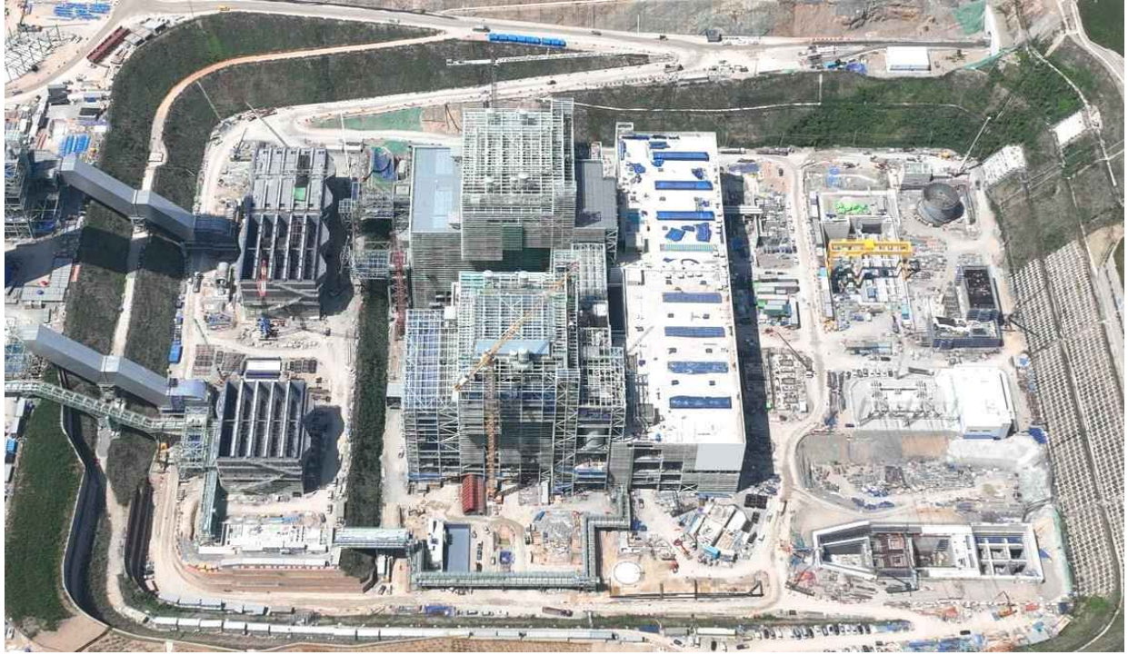
본부지 시공 전경
