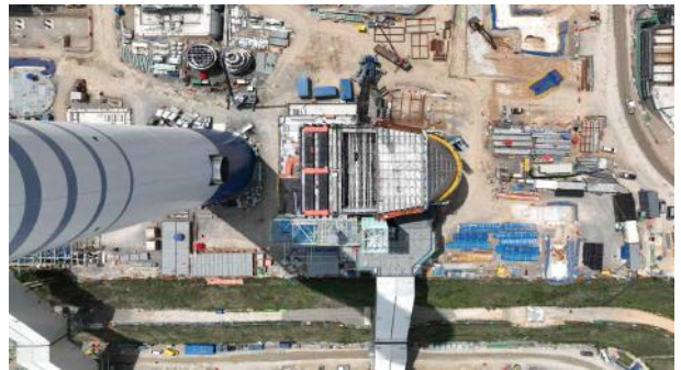
탈황 #1 흡수탑 설치
