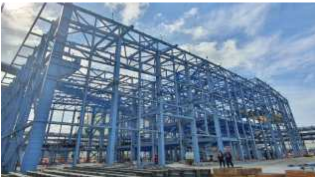
종합 정비동 구조물공사
