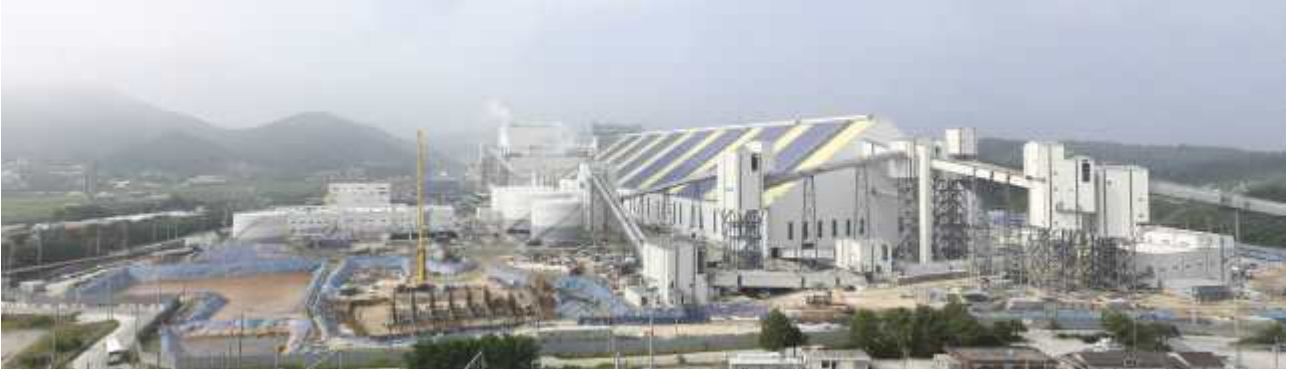
강릉안인 1,2호기 건설사업 전경
