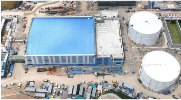
용수환경건물 및 현장제작탱크 설치
