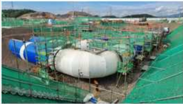
냉각수 지중 배관 설치
