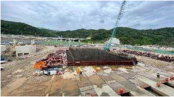
케이슨 기초거푸집 및 철근조립
