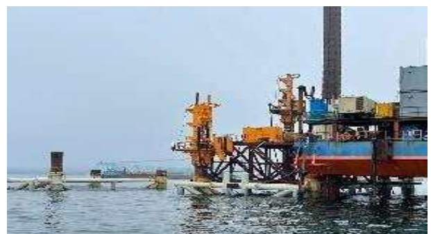
하역부두 자켓 설치
