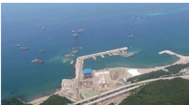
항만 공사 전경
