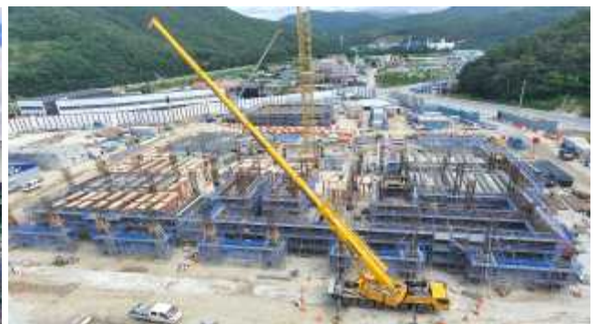
종합사무실 구조물 공사
