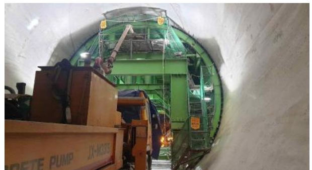
배수터널 라이닝 Con'c 타설
